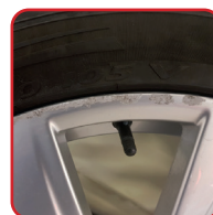
Fälgar med deformerade kanter eller sidokast.
